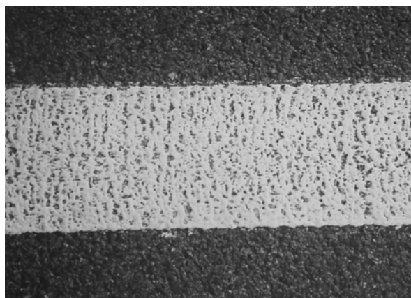
Obr. 3: Příklady VDZ typu II – strukturální VDZ
