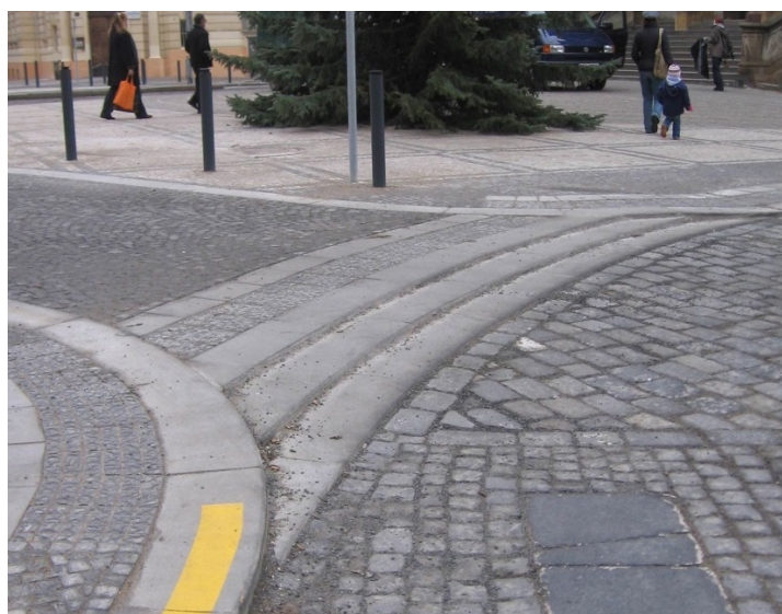
Obr. 11 Detail stupňovitého tvaru nájezdové rampy
