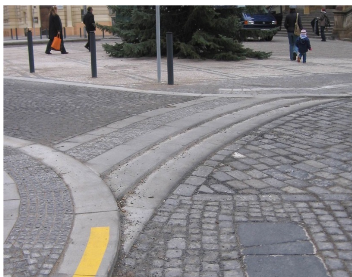
Obr. 11 Detail stupňovitého tvaru nájezdové rampy
