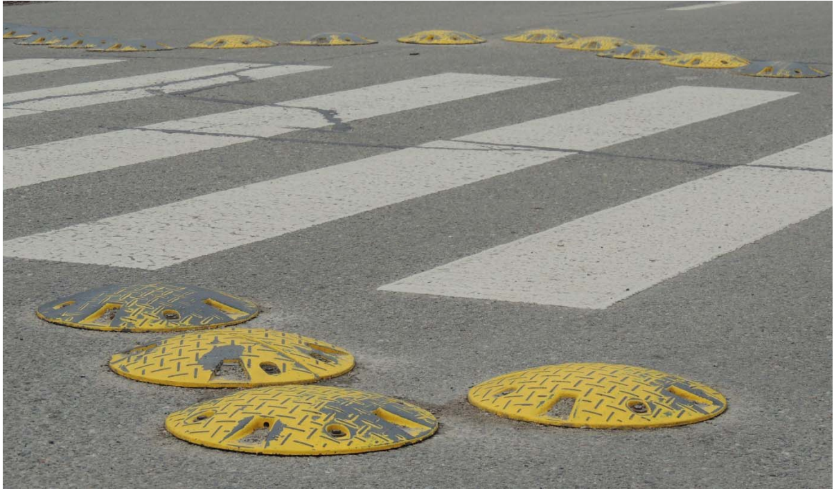
Obr. 16 Příklad umístění polštářů tvořených z prefabrikátů
