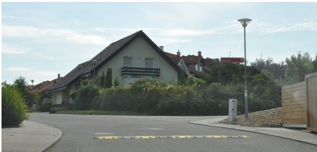
Obr. 4 Příklad umístění krátkého zpomalovacího prahu
