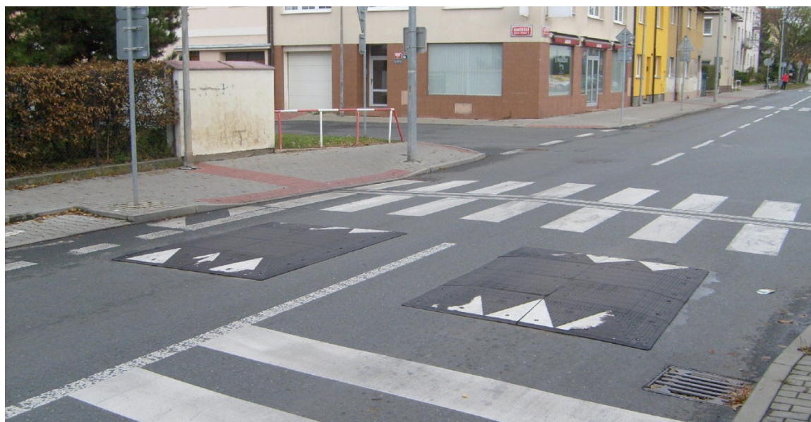
Obr. 13 Příklad umístění zpomalovacích polštářů před přechodem pro chodce
