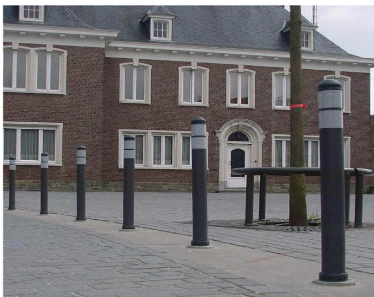
Obrázek 5 - Příklad umístění zvýrazňujících sloupků
