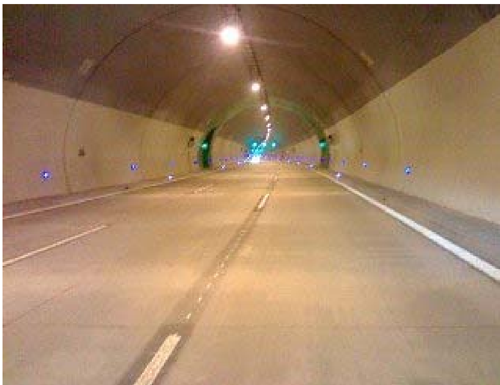
Obrázek 10 – Použití vodicích trvale svítících knoflíků v tunelu
