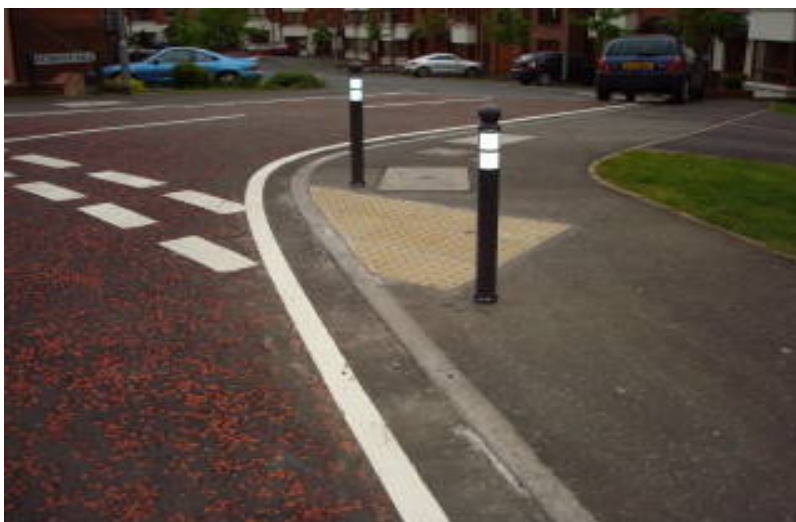
Obrázek 4 - Příklad umístění zvýrazňujících sloupků
