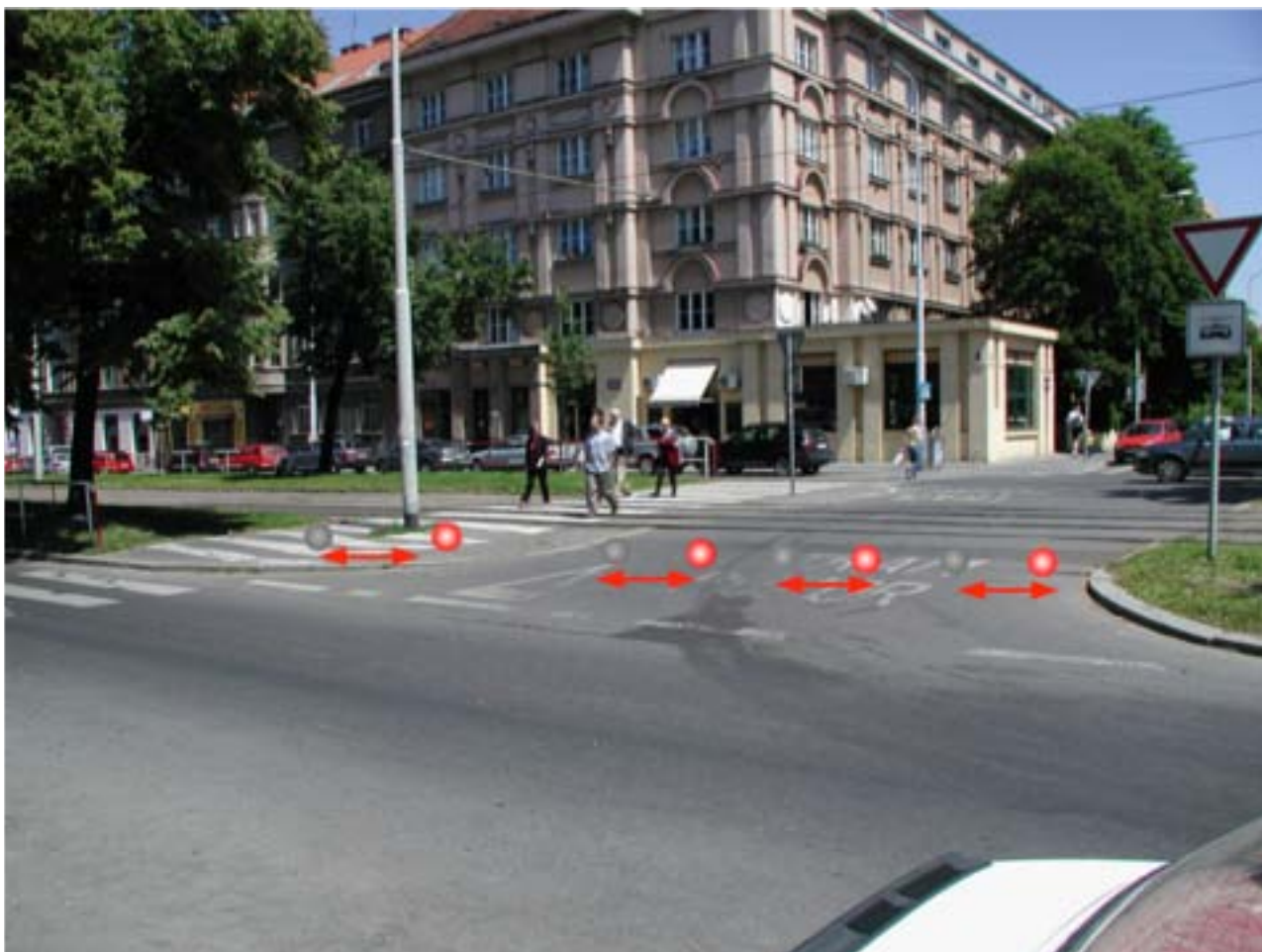
Vizualizace přijíždějící tramvaje zemními LED návěstidly– POZOR tramvaj!
