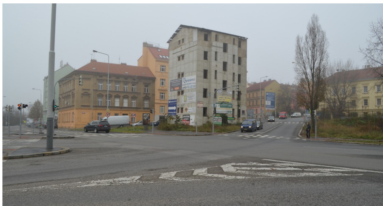
Křižovatka ulic Prosecká a Čuprova, Praha 8 - Libeň – stav listopad 2016
