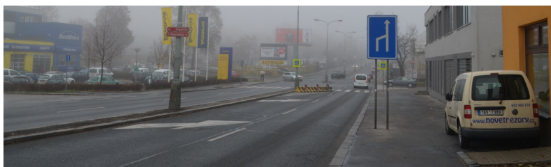
Přechody pro chodce na ulici Úvalská, Praha 10 - Strašnice – stav listopad 2016
