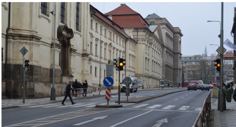
Přechod pro chodce na ulici Resslova, Praha 2 – Nové Město – stav listopad 2016
